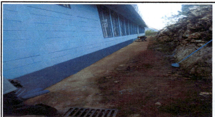
Foto 4: se evidencia la finalizacion de aplicación de pintura en el exterior
