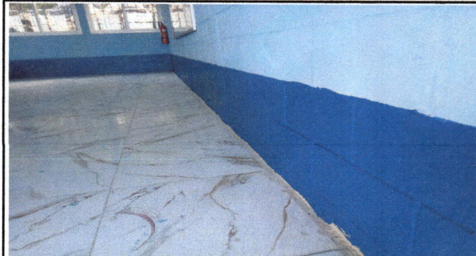
Foto 2: se observa en la fotografia la finalizacion de instalacion pisos ceramico aula II
