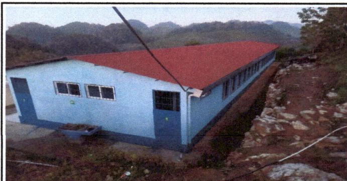
Foto 6: luego de finalizar la aplicación de pintura anticorrosiva a las laminas
