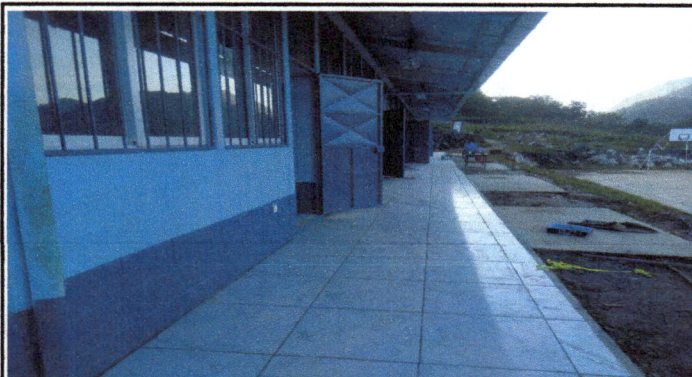
Foto 3: Se evidencia en la imagen la finalizacion de instalacion pisos ceramico en el corredor
